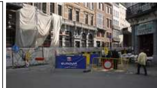
Le gros chantier début octobre
